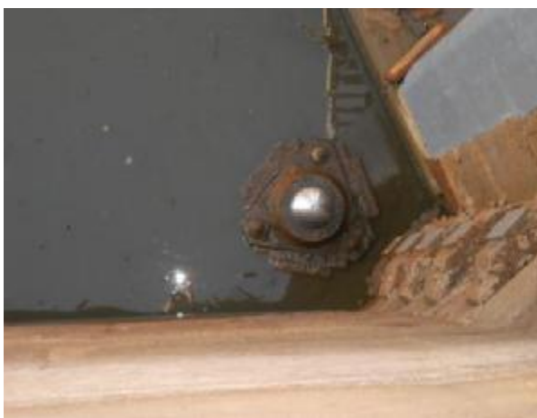
patní ložisko vzpěrných vrat (čep - lůžko)
